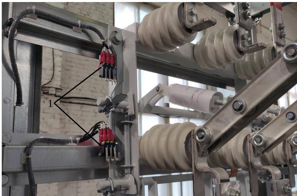
Рис. 6.2. Размещение блок-контактов на разъединителе РВЗ-10
