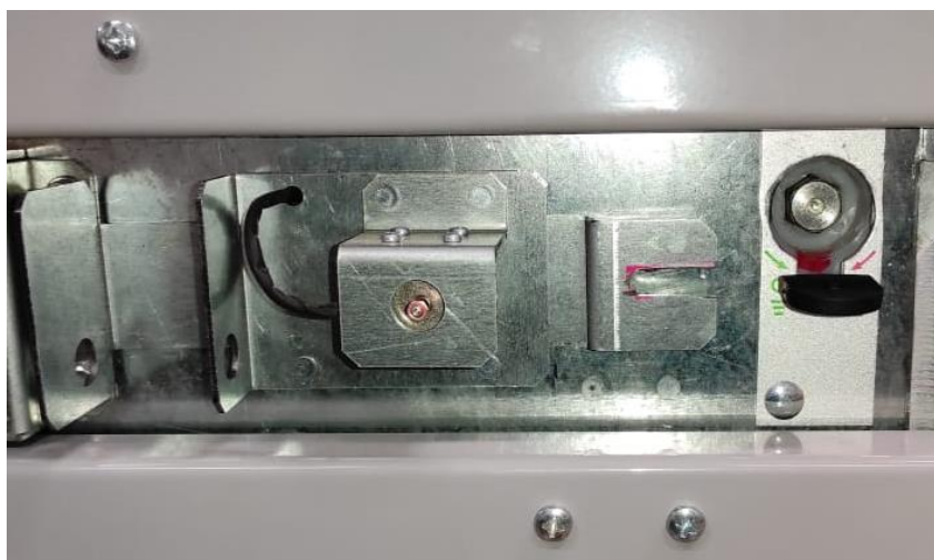
Рис. 10.3 Электромагнитная блокировка (12) привода заземлителя
